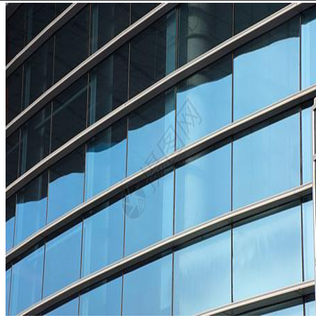
玻璃幕墙照片
