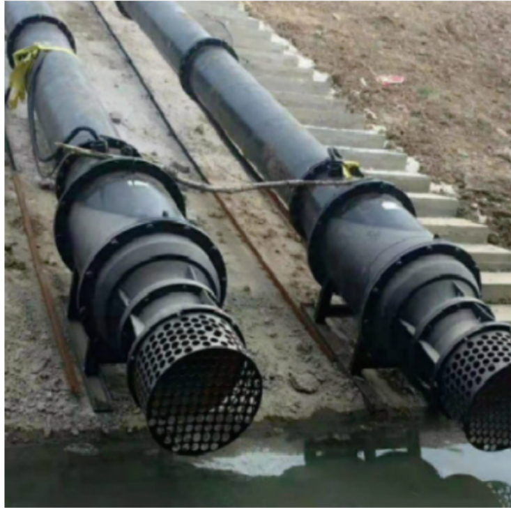
图 2-1 轴流潜水泵雪橇式安装类似工程图片
